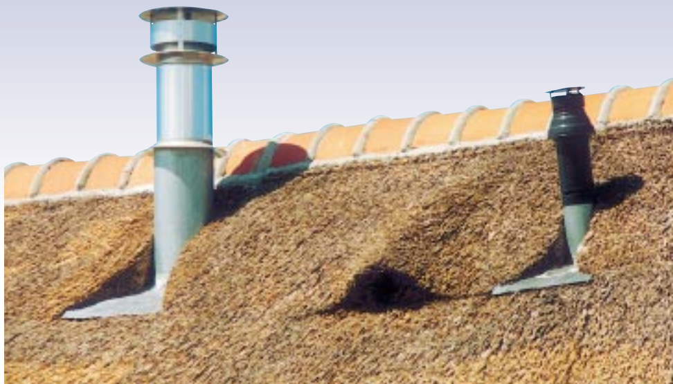
(Foto: Vakfederatie Rietdekkers)
