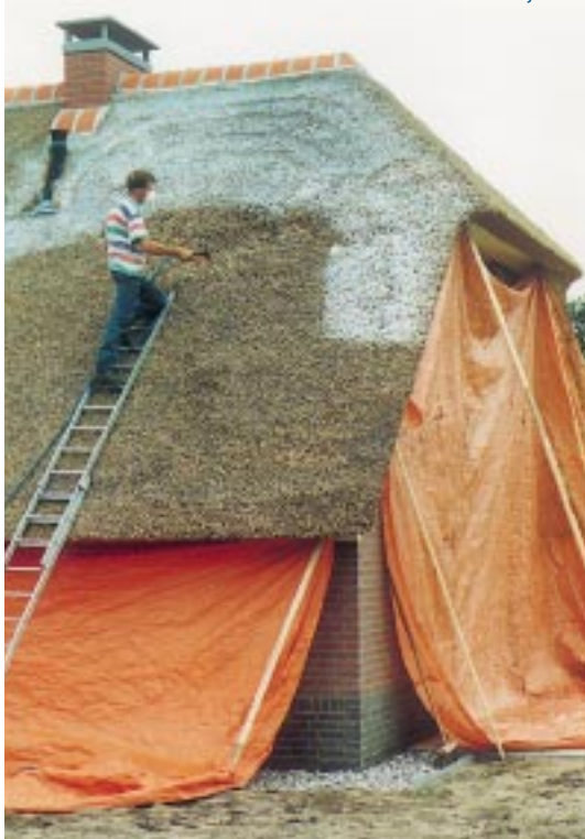
(Foto: Vakfederatie Rietdekkers)
